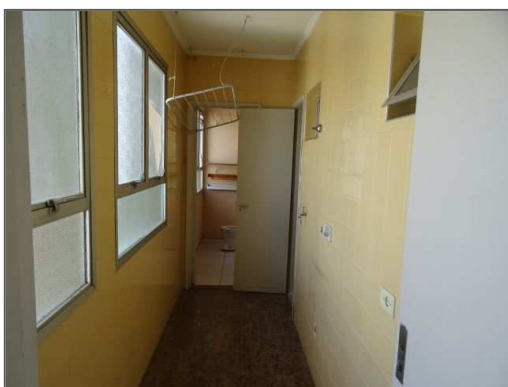
F8. Área de serviço.
