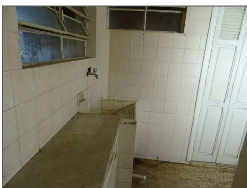
F21. Área de serviço.
