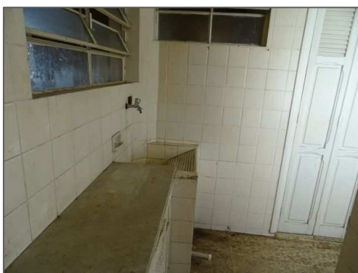
F21. Área de serviço.
