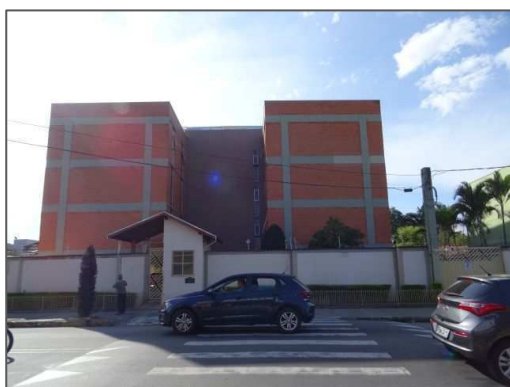
F29. Fachada para a Av. Fortunato Moreira.
