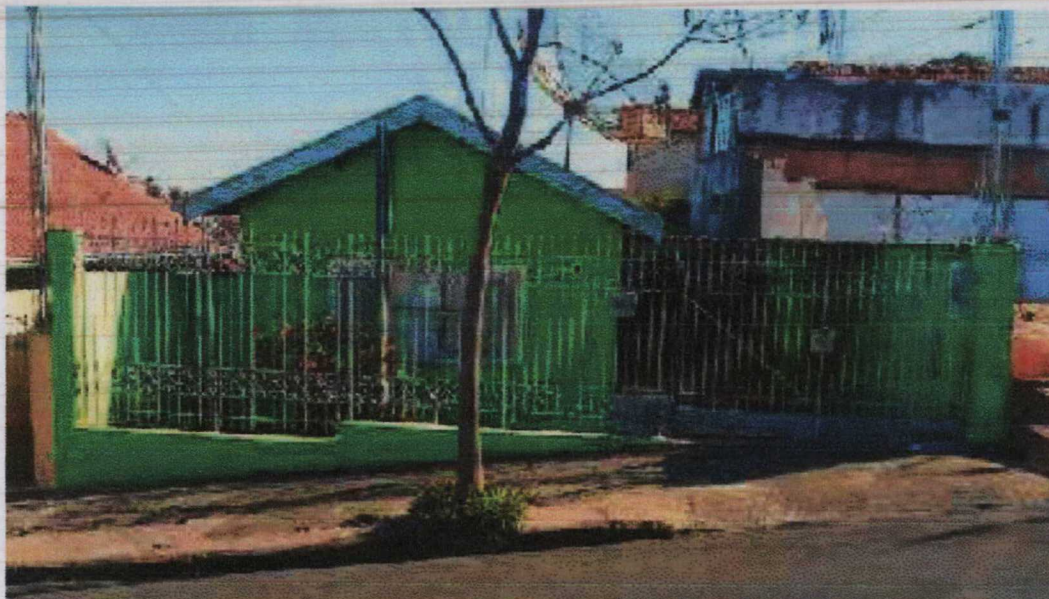
FOTO 3 – Vista da fachada principal do imóvel com frente para a Rua João Crisóstomo.
