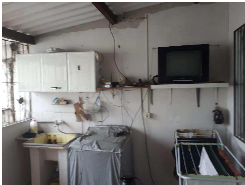
Foto 11: Vista da área de serviço coberta do imóvel
