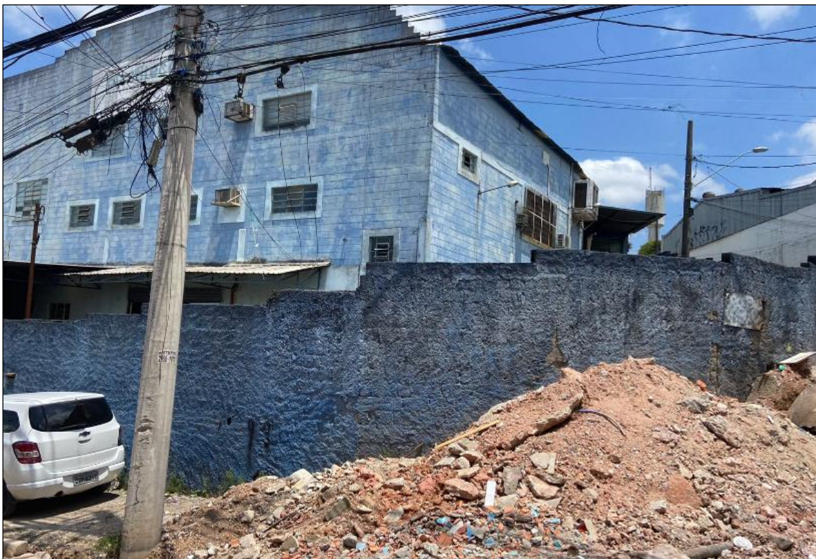
Figura 12: Fachada do imóvel avaliando.
