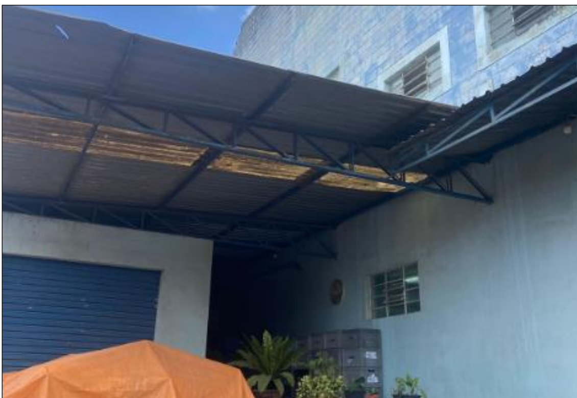
Figura 13: Entrada do imóvel avaliando.
