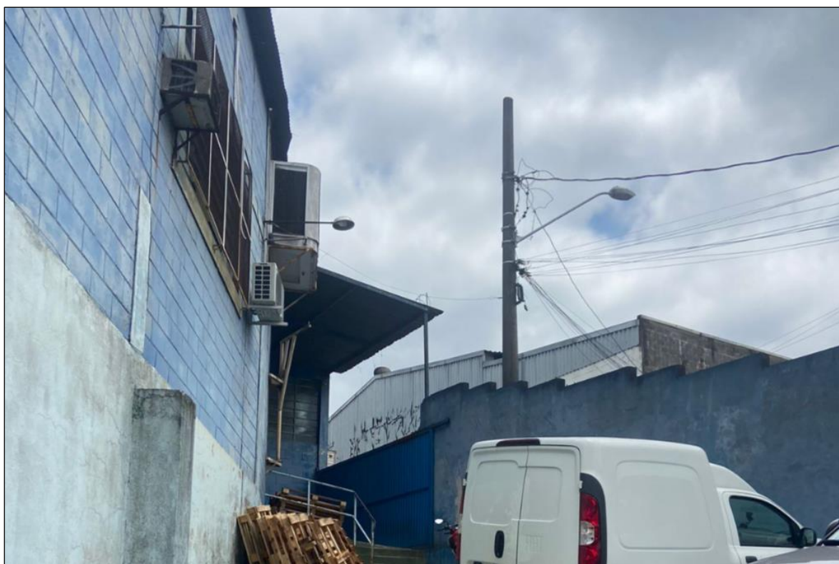
Figura 25: Área externa do imóvel avaliando.
