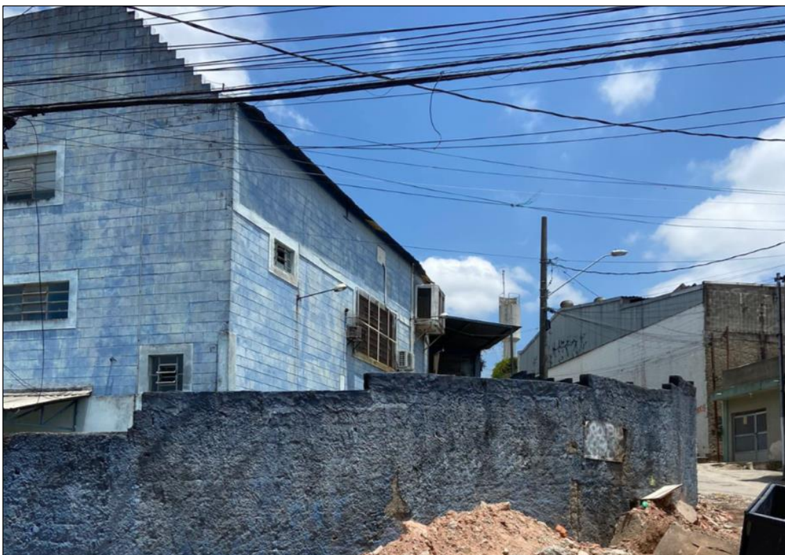
Figura 13: Fachada do imóvel avaliando.
