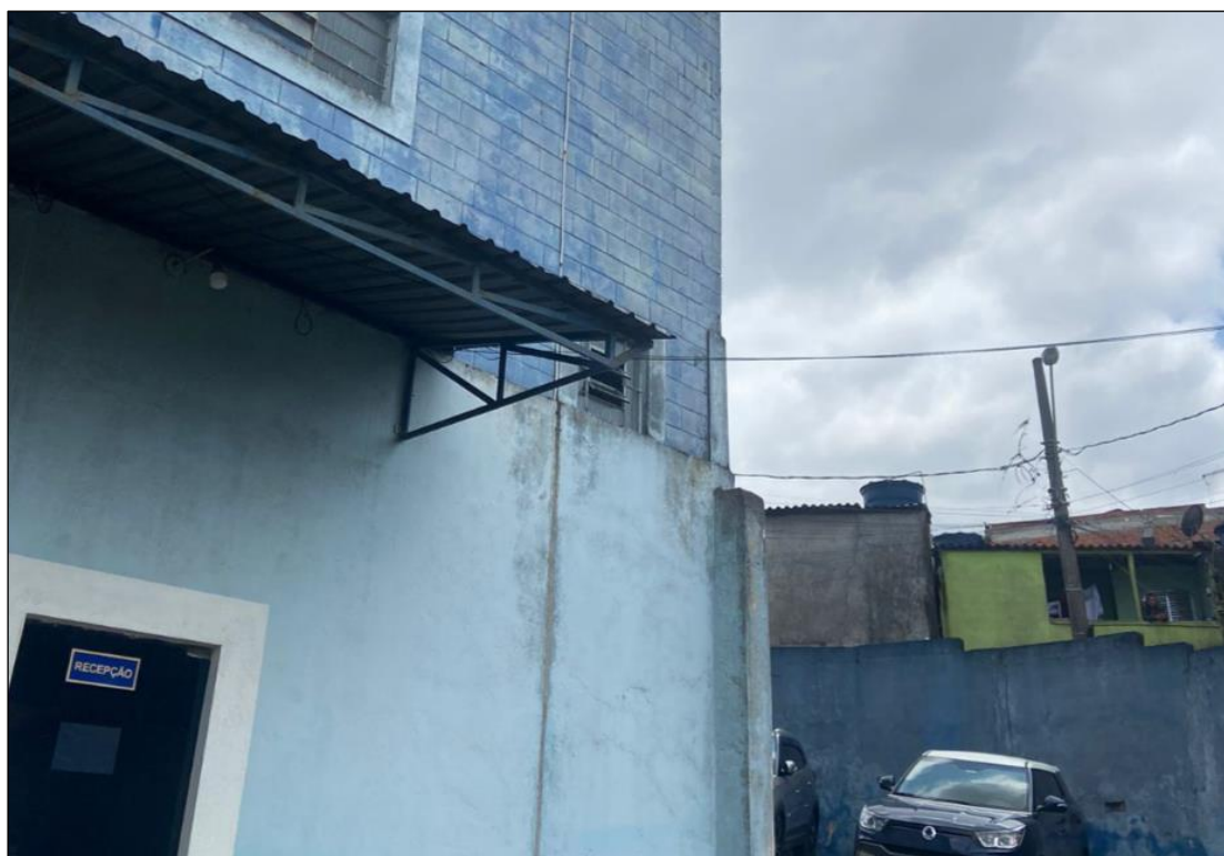
Figura 15: Entrada do imóvel avaliando.
