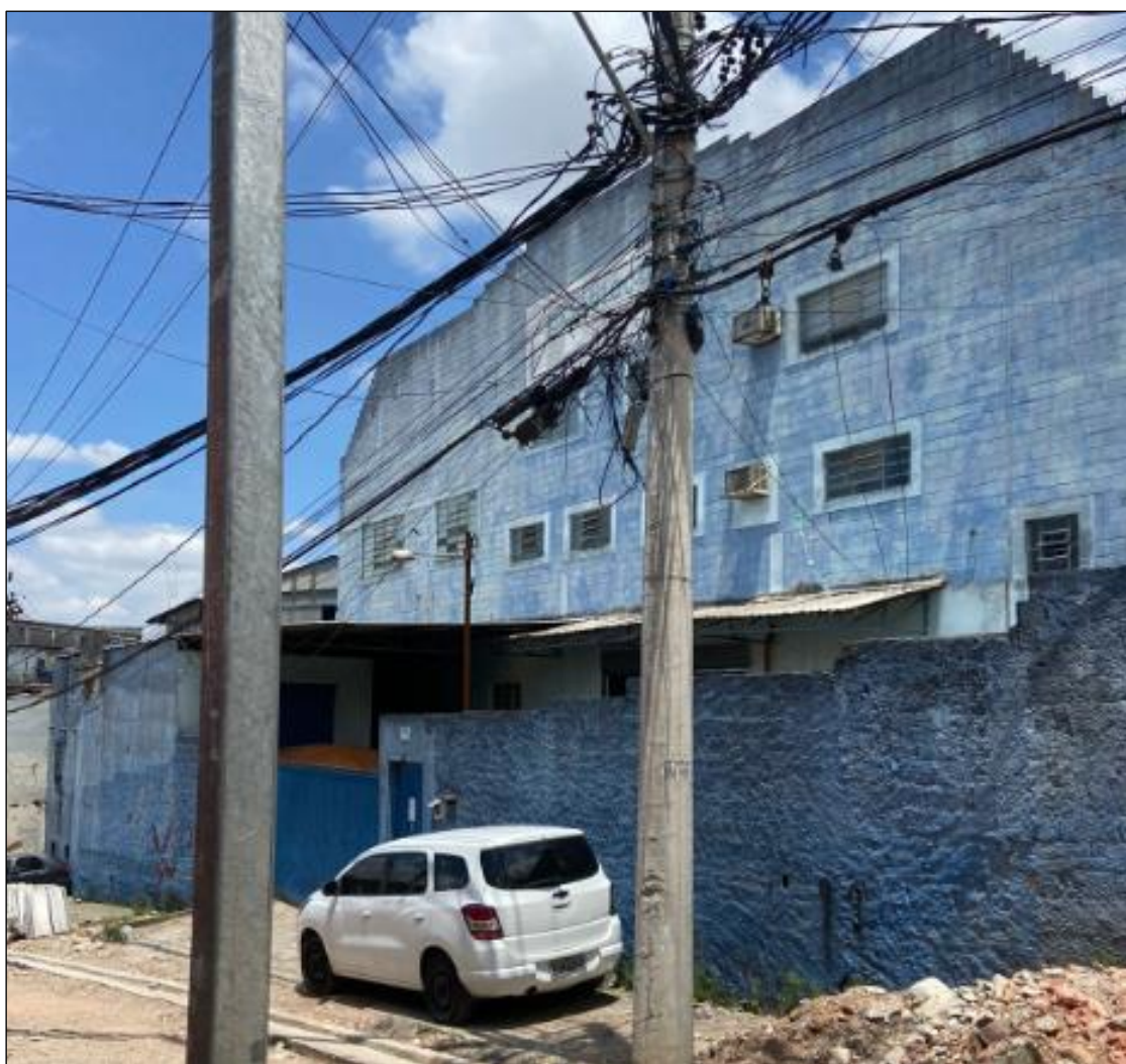
Figura 1: Fachada do imóvel avaliando.
