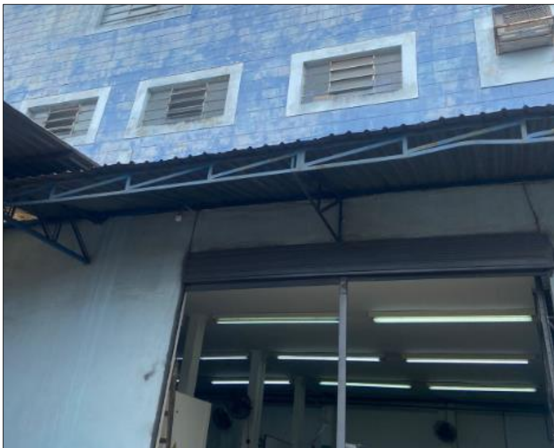
Figura 14: Entrada do imóvel avaliando.
