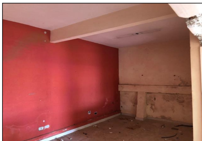
Vista interna da edificação
