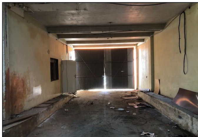
Vista interna da edificação - Galpão
