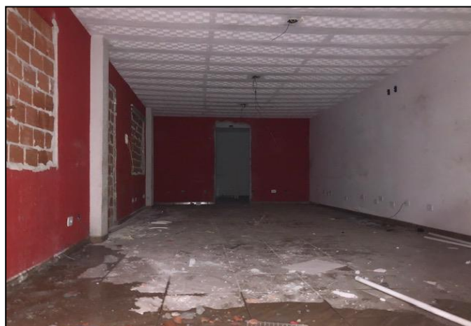
Vista interna da edificação - Galpão
