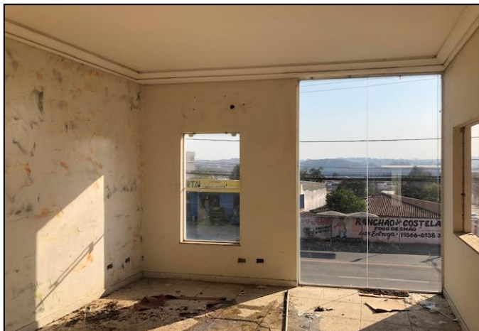
Vista interna da edificação
