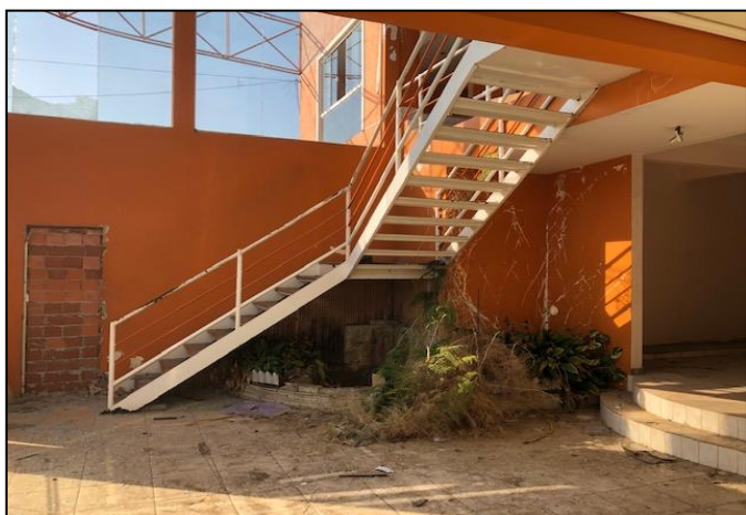
Vista interna da edificação
