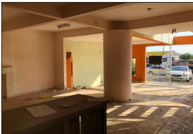
Vista interna da edificação
