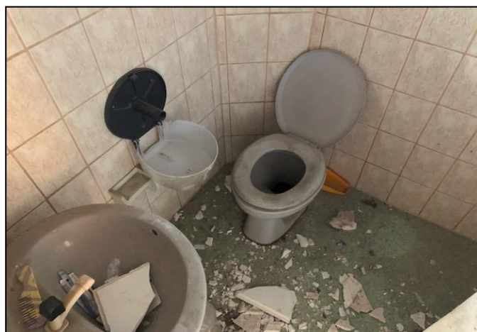
Vista interna da edificação
