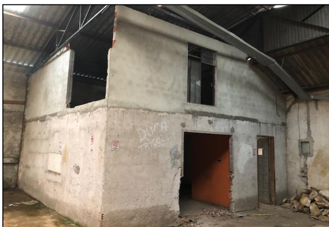
Vista interna da edificação - Galpão
