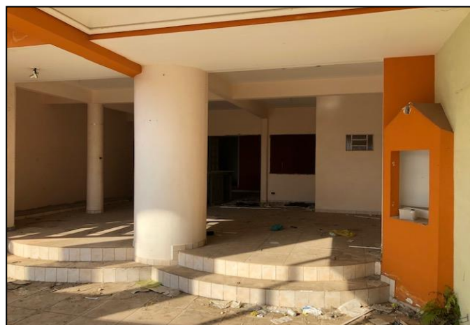
Vista interna da edificação
