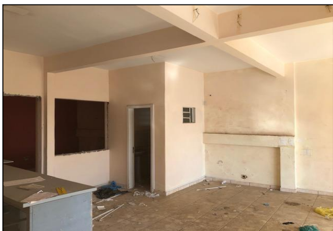
Vista interna da edificação
