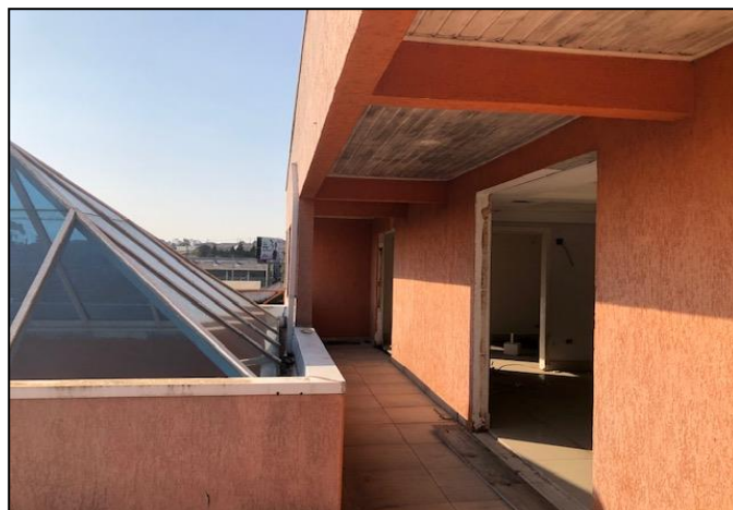
Vista interna da edificação
