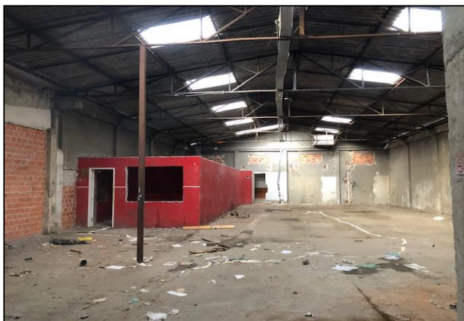
Vista interna da edificação - Galpão
