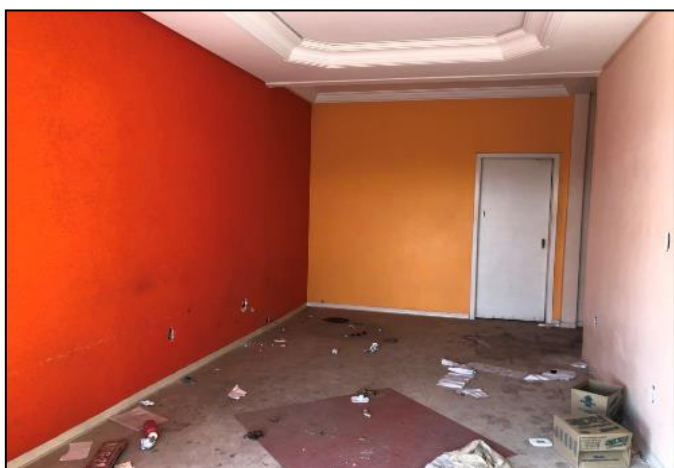
Vista interna da edificação
