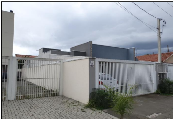
Fachada - Casa A
