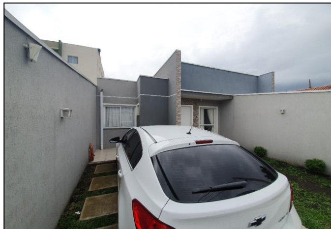
Fachada - Casa A
