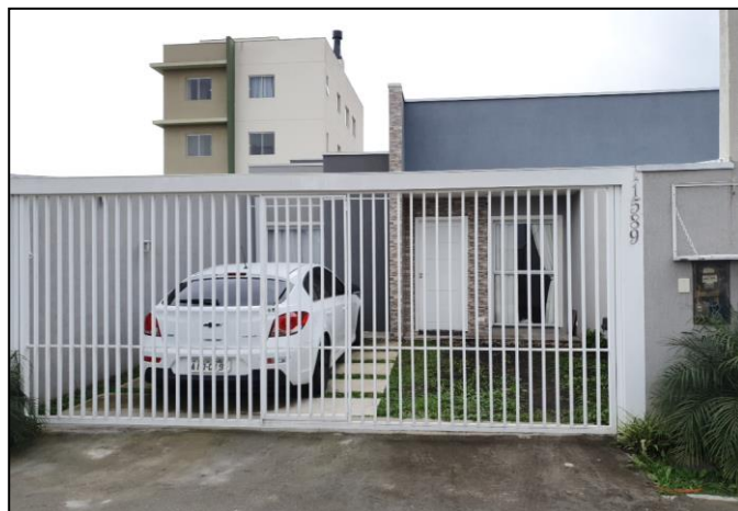
Fachada - Casa A
