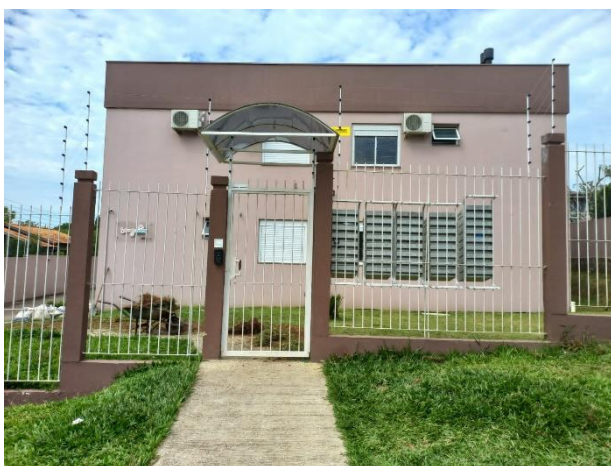
Vista parcial do edifício
