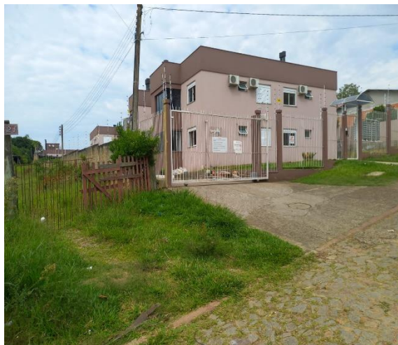
Vista parcial do edifício
