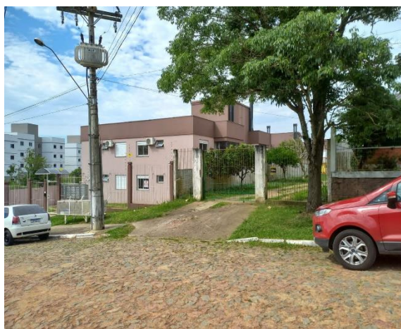
Vista parcial do edifício
