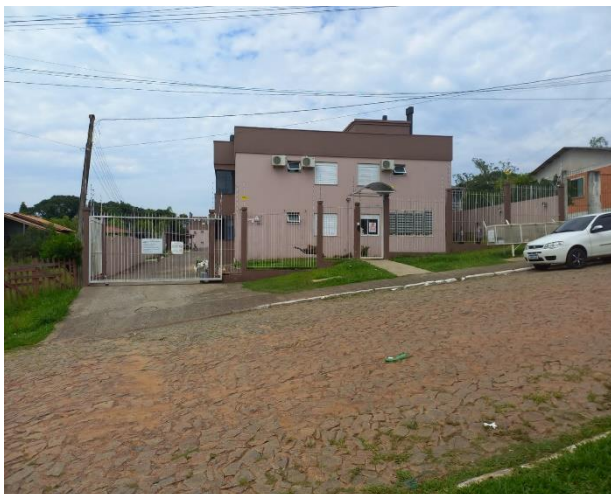
Vista parcial do edifício
