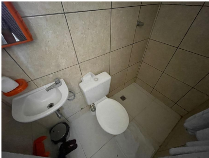
Representação Banheiro Suíte Descrição Data Foto 04/12/2021
