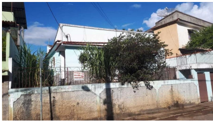
Representação Fachada Principal Descrição Data Foto 06/04/2021
