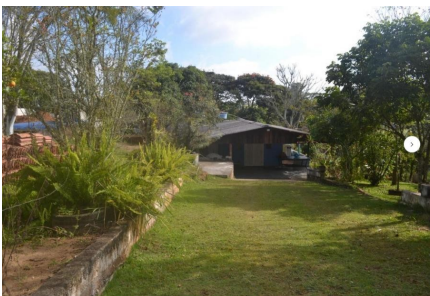
Representação Fachada Principal Descrição Data Foto 23/02/2022
