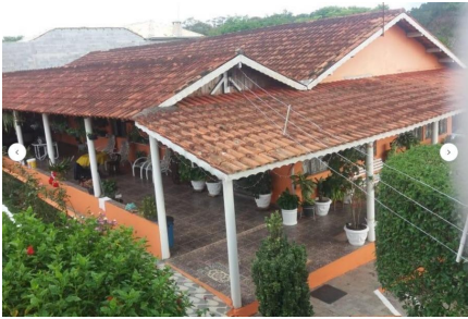
Representação Fachada Principal Descrição Data Foto 23/02/2022
