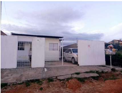
Representação Fachada Principal Descrição Data Foto 04/05/2021
