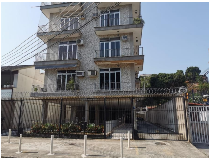
Representação Fachada Principal Descrição Data Foto 26/09/2021
