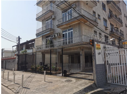
Representação Fachada Principal Descrição Data Foto 26/09/2021
