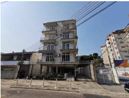
Representação Fachada Principal Descrição Data Foto 26/09/2021
