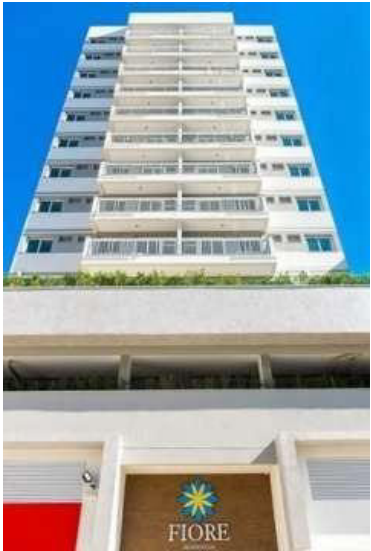
Representação Fachada Principal Descrição Data Foto 31/08/2021
