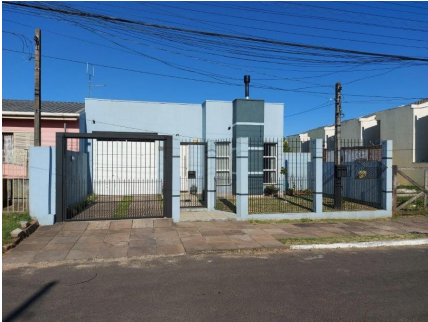
Representação Fachada Principal Descrição Data Foto 28/10/2021
