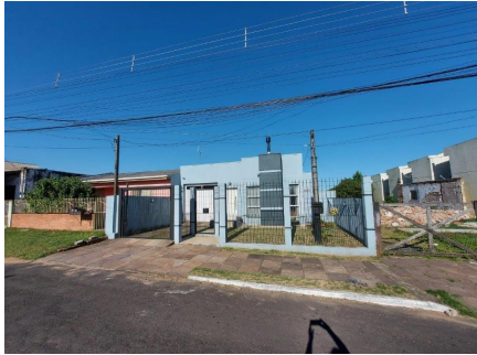
Representação Fachada Principal Descrição Data Foto 28/10/2021
