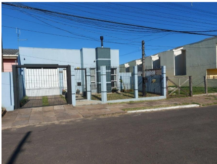
Representação Fachada Principal Descrição Data Foto 28/10/2021
