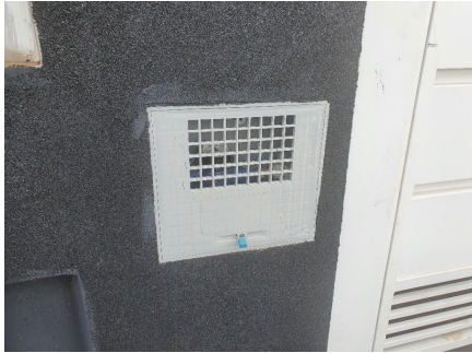
Representação Fachada Principal Descrição Cavalete Data Foto 28/04/2022
