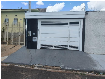
Representação Fachada Principal Descrição Data Foto 28/04/2022
