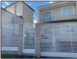
Representação Fachada Principal Descrição Data Foto 02/02/2021
