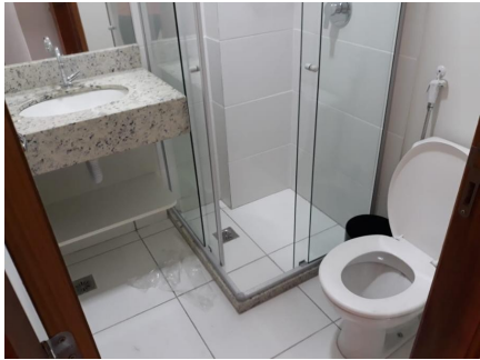
Representação Banheiro Suíte Descrição Data Foto 01/04/2020
