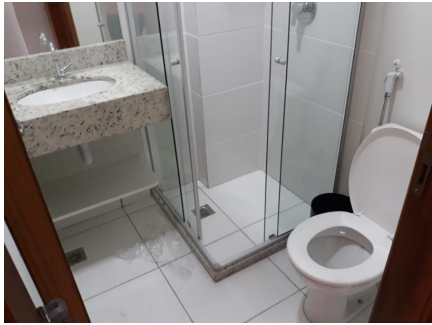
Representação Banheiro Suíte Descrição Data Foto 01/04/2020
