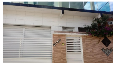
Representação Fachada Principal Descrição Data Foto 25/06/2021
