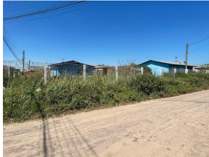
Representação Fachada Principal Descrição Data Foto 13/01/2022
