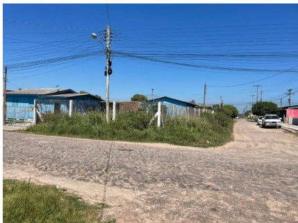
Representação Fachada Principal Descrição Data Foto 13/01/2022
