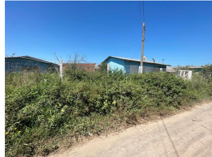
Representação Fachada Principal Descrição Data Foto 13/01/2022
