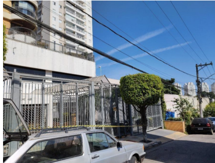
Representação Fachada Principal Descrição Data Foto 09/07/2022
