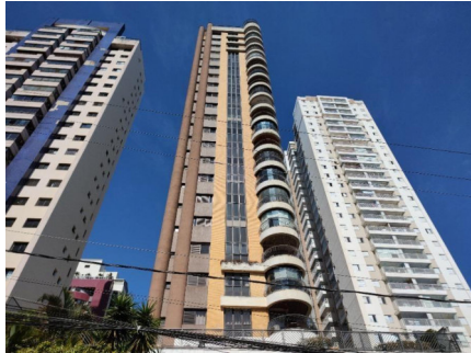
Representação Fachada Principal Descrição Data Foto 09/07/2022
