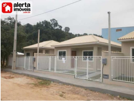
Representação Fachada Principal Descrição
