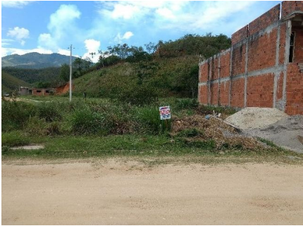
Representação Fachada Principal Descrição
