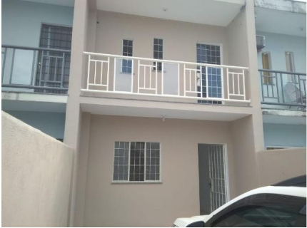
Representação Fachada Principal Descrição
