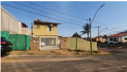
Representação Fachada Principal Descrição Data Foto 05/09/2022
