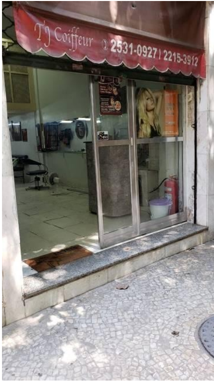
Representação Fachada Principal Descrição Data Foto 01/08/2022
