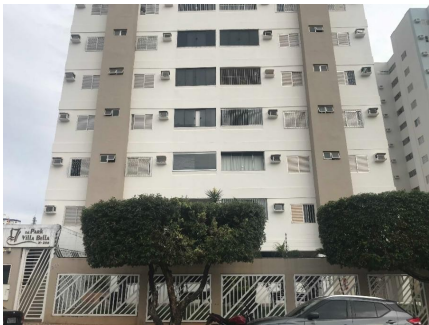
Representação Fachada Principal Descrição Data Foto 29/04/2021
