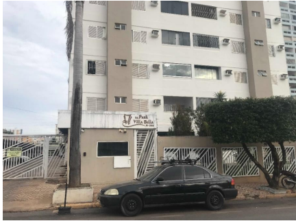
Representação Fachada Principal Descrição Data Foto 29/04/2021
