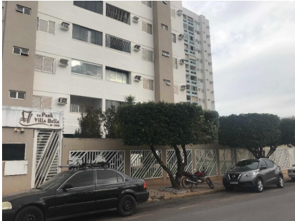
Representação Fachada Principal Descrição Data Foto 29/04/2021
