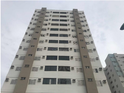
Representação Fachada Principal Descrição Data Foto 29/04/2021
