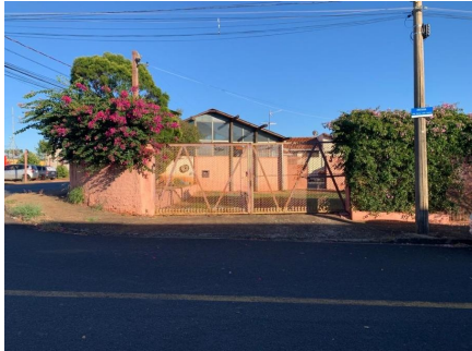
Representação Fachada Principal Descrição Data Foto 14/06/2021
