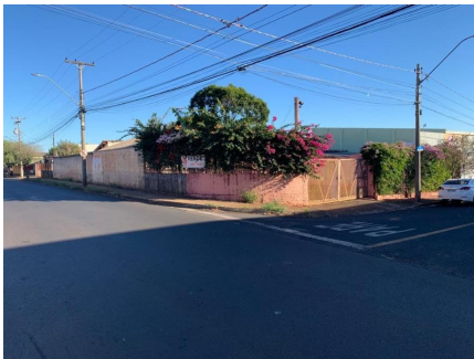
Representação Fachada Principal Descrição Data Foto 14/06/2021
