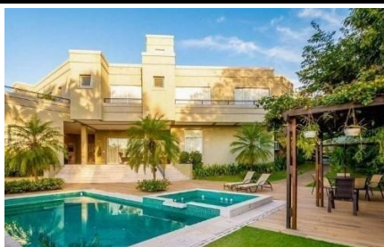
Representação Fachada Principal Descrição Data Foto 21/07/2022
