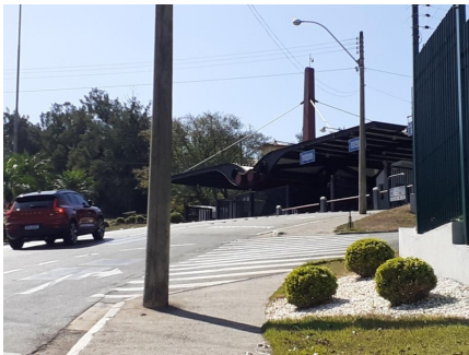
Representação Fachada Principal Descrição CONDOMINIO Data Foto 21/07/2022
