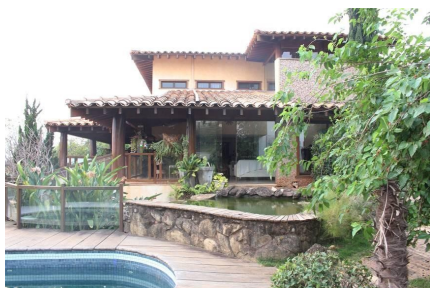
Representação Fachada Principal Descrição Data Foto 21/07/2022
