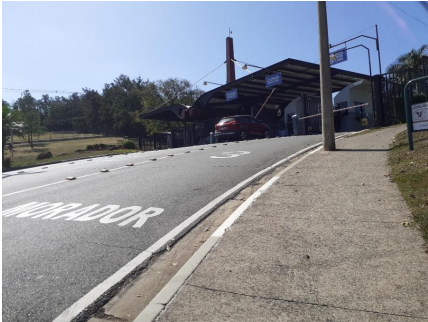
Representação Fachada Principal Descrição CONDOMINIO Data Foto 21/07/2022
