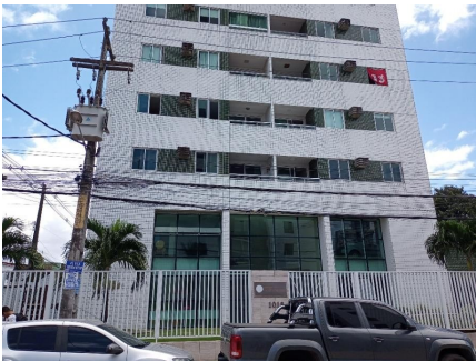
Representação Fachada Principal Descrição CONDOMÍNIO Data Foto 16/09/2022
