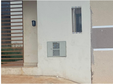
Representação Fachada Principal Descrição Cavalete Data Foto 21/01/2022
