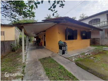
Representação Fachada Principal Descrição Data Foto
