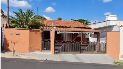
Representação Fachada Principal Descrição FACHADA IMÓVEL
