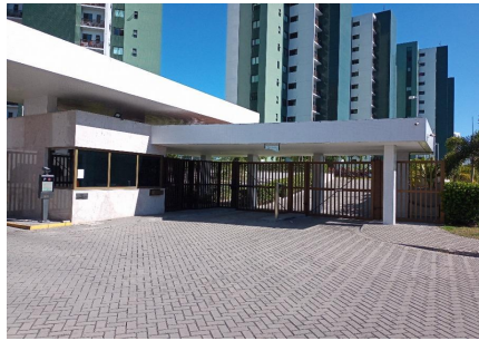
Representação Fachada Principal Descrição Data Foto 02/11/2022
