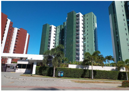
Representação Fachada Principal Descrição Data Foto 02/11/2022
