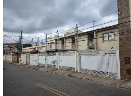
Representação Vista da Rua Descrição VIZINHOS Data Foto 31/08/2022
