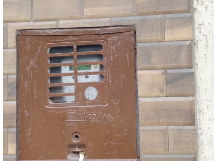
Representação Vista da Rua Descrição RELÓGIO Data Foto 31/08/2022
