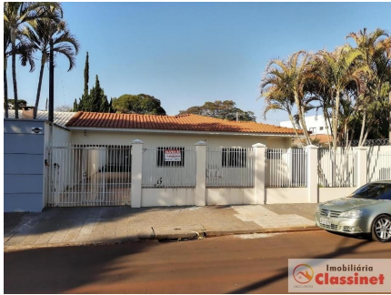
Representação Fachada Principal Descrição Data Foto
