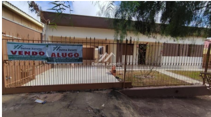
Representação Fachada Principal Descrição Data Foto
