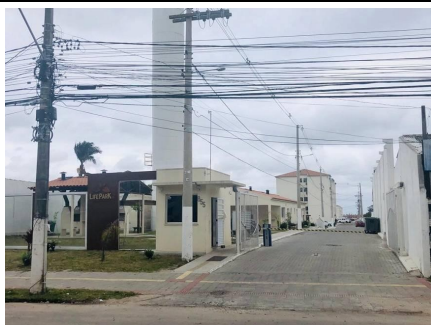
Representação Fachada Principal Descrição Data Foto
