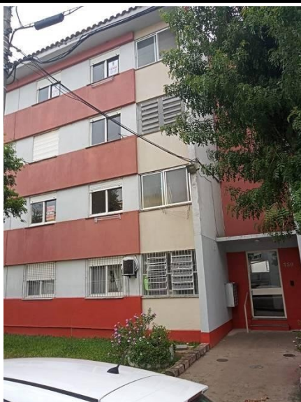
Representação Fachada Principal Descrição Data Foto
