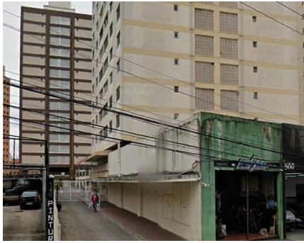
Representação Fachada Principal Descrição Data Foto 14/06/2022
