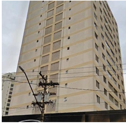
Representação Fachada Principal Descrição Data Foto 14/06/2022
