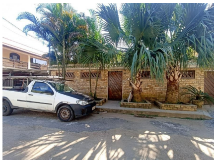
Representação Fachada Principal Descrição Fachada Data Foto 18/05/2022
