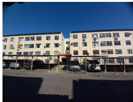
Representação Fachada Principal Descrição FACHADA DO CONDOMÍNIO Data Foto 25/04/2022
