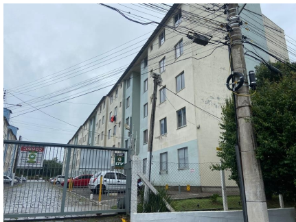
Representação Fachada Principal Descrição Data Foto
