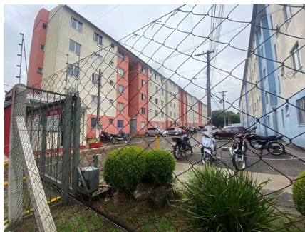
Representação Fachada Principal Descrição Data Foto 04/02/2022
