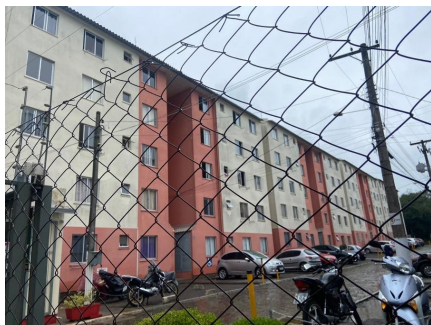
Representação Fachada Principal Descrição Data Foto 04/02/2022
