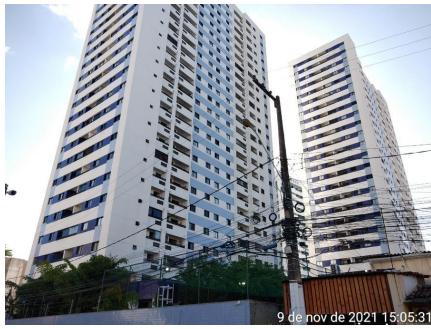
Representação Fachada Principal Descrição Data Foto 09/11/2021
