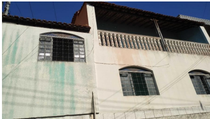
Representação Fachada Principal Descrição Data Foto 14/06/2021
