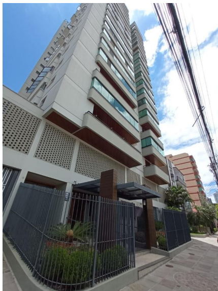
Representação Fachada Principal Descrição Data Foto 15/01/2021
