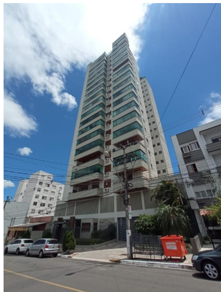
Representação Fachada Principal Descrição Data Foto 15/01/2021
