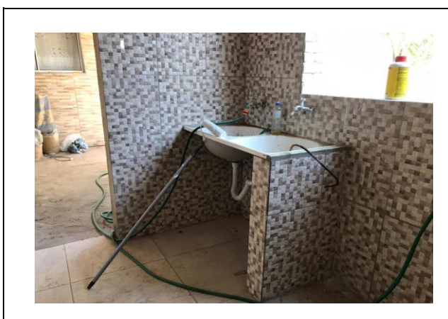
ÁREA DE SERVIÇO COBERTA
