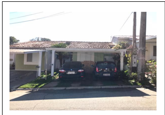
FACHADA DO AVALIANDO
