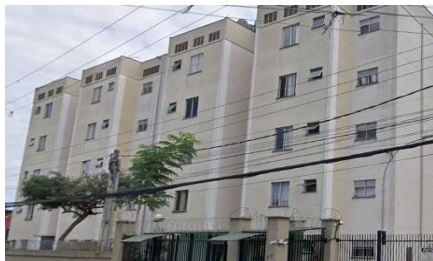
Representação Fachada Principal Descrição Data Foto 17/07/2023
