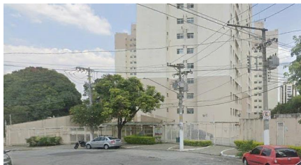
Representação Fachada Principal Descrição Data Foto 04/12/2022
