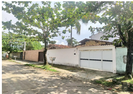
Representação Vista da Rua Descrição VIZINHO DIREITO Data Foto 29/11/2022
