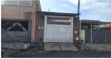
Representação Fachada Principal Descrição Data Foto 01/03/2023
