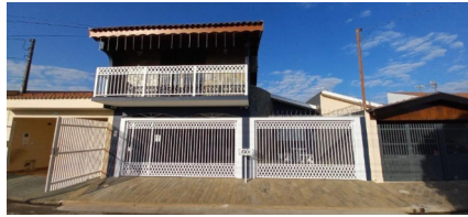
Representação Fachada Principal Descrição Data Foto 26/08/2022
