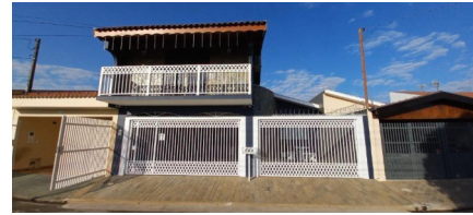
Representação Fachada Principal Descrição Data Foto 26/08/2022
