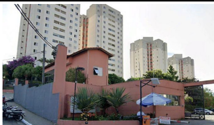
Representação Fachada Principal Descrição Data Foto 29/10/2022
