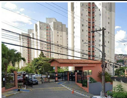
Representação Fachada Principal Descrição Data Foto 29/10/2022
